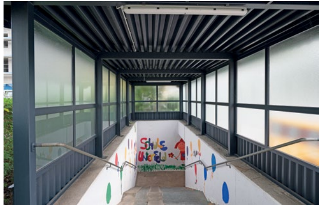
Verglasungen, Verkleidungsbleche und Fensterrahmen wurden saniert.
