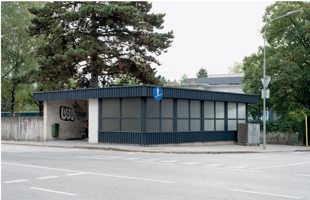
Neue Einhausung der Unterführung in der Harderstraße
