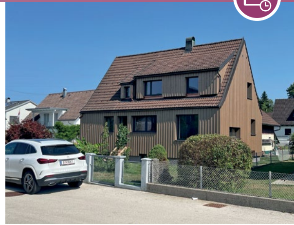
Beispiel für eine Sanierung in Lauterach. Foto: Energieinstitut
