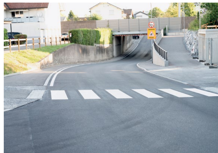
Neuer, sicherer Fußgängerübergang in der Unterfeldstraße. Die Bepflanzung der Bauminiseln erfolgt im Herbst.
