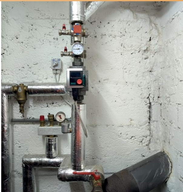
Nachträglich selbstgedämmte Heizungsrohre im Keller
