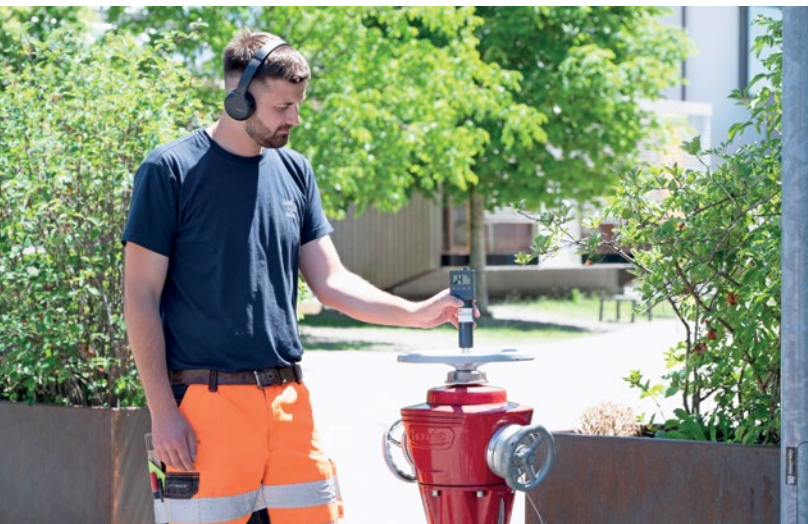
Mit einem Abhorchgerät untersucht Raphael Köstinger vom Wasserwerk die Leitungen auf undichte Stellen.
