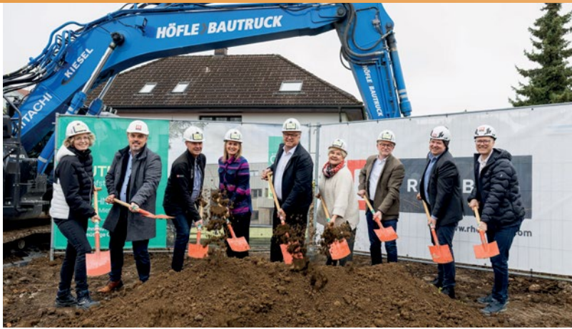
Spatenstich in der Bahnhofstraße, Foto: Rhomberg Bau
