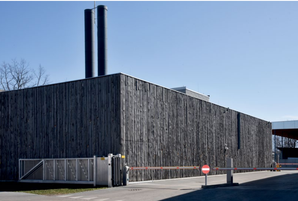
Das Biomasse-Heizkraftwerk in der Industriestraße erzeugt aus Hackschnitzeln und Waldhackgut saubere Wärme mit hoher Effizienz.
