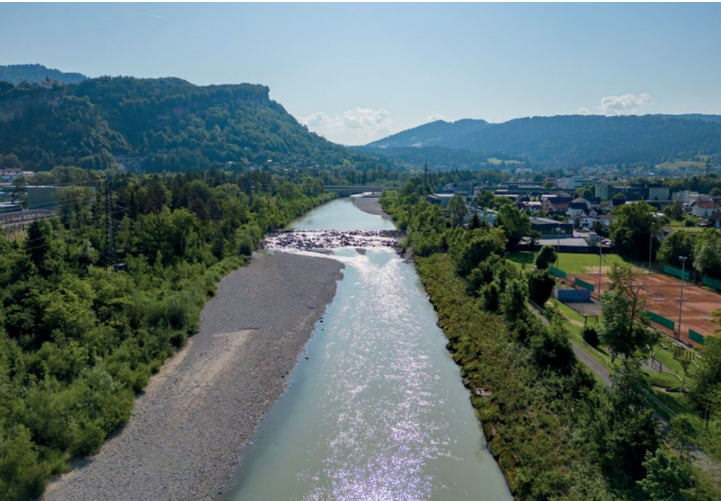
Der nächste Bauabschnitt umfasst die beiden Rampenbauwerke Höhe Lauterach Tennisplatz und Brücke Wolfurt/Kennelbach. | Foto: Dietmar Stiplovsek
