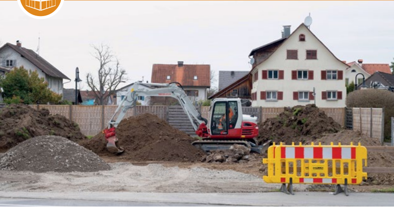
Die Bauarbeiten für den Friedhofsparkplatzes schreiten schnell voran.
