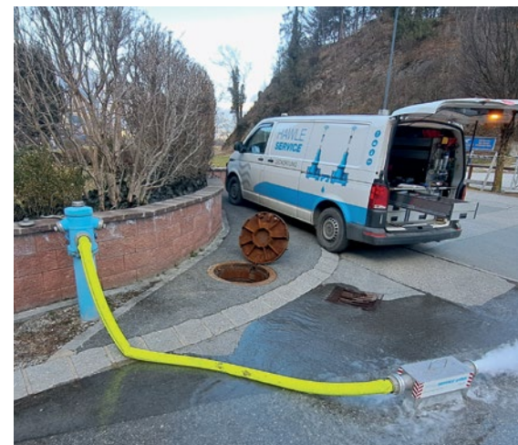
Die Firma Hawle Service überprüft das Wasserleitungsnetz.
