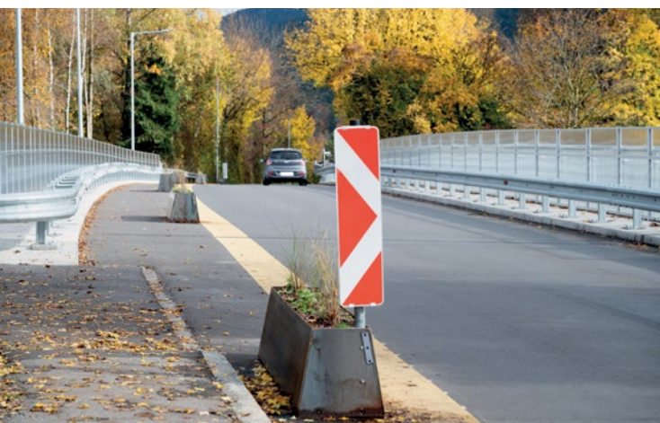
Breite Gehwege und Pflanzentröge auf der Autobahnbrücke Wolffurterstraße.
