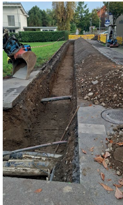
Anschluss der Polizeiinspektion an das Nahwärmenetz
