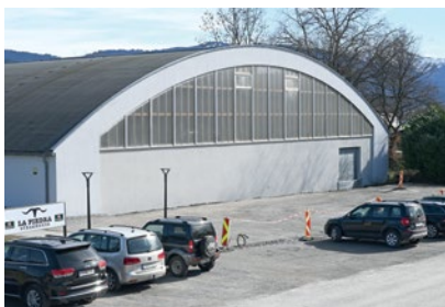
Bald stehen vor der Tennishalle Lauterach mehr Parkplätze zur Verfügung.
