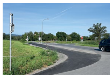
Baufortschritt Mitte August
