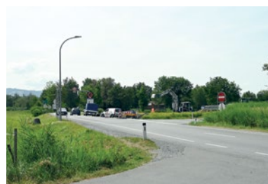
Baustart im Juli
