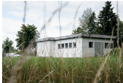
Bild oben: Wasserwerk Bild links: Horizontalfilterbrunnen
