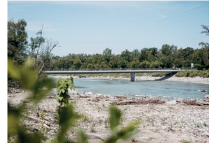
Der Hochwasserschutz- und Lebensraumprojekt Bregenzerach sorgt für nachhaltigen Schutz der Bevölkerung in den Gemeinden, Lauterach, Bregenz, Hard, Kennelbach und Wolfurt
