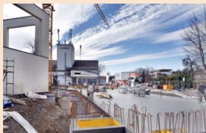
Im nördlichen Teil der SeneCura wird die bestehende Terrasse abgebaut, um Platz für den beginnenden Zubau im 3. Stock aufzubauen
