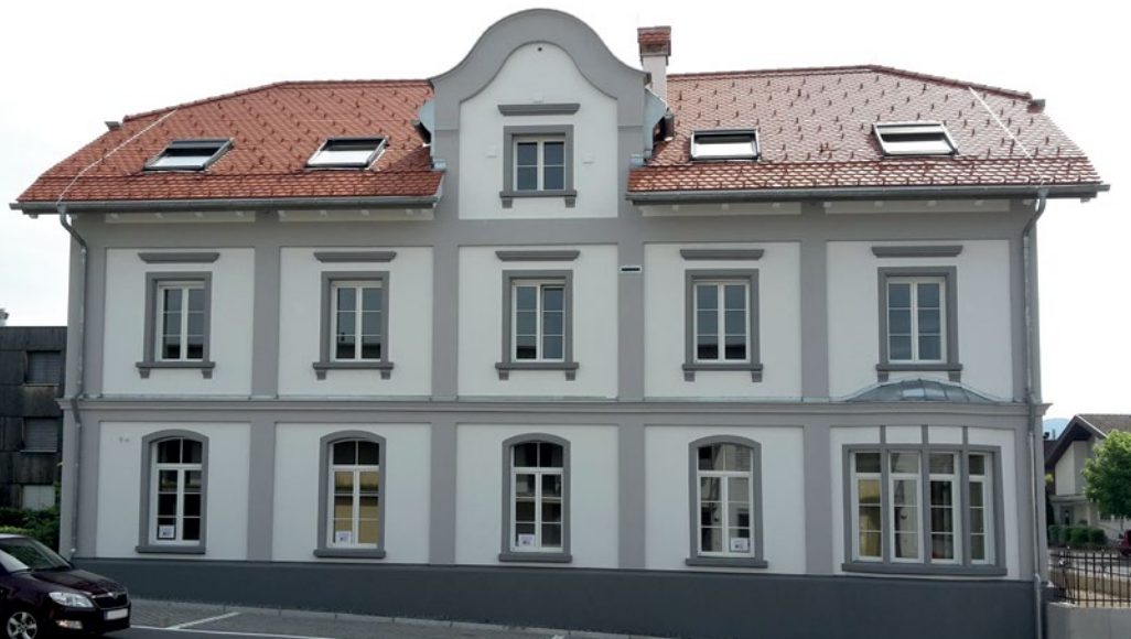
Das traditionsreiche Haus „Karl-Höll-Straße 18“, das letzte sichtbare Zeichen des ehemaligen größten Arbeitgebers in unserer Gemeinde, die Tubenfabrik Karl Höll
