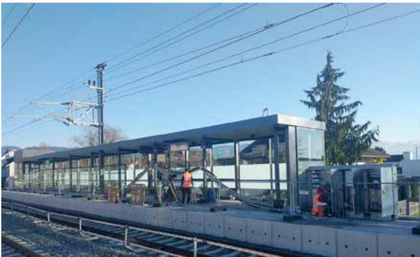
Die Bauarbeiten an der ÖBB Haltestelle Unterfeld schreiten zügig voran. In der Kaltenbrunnenstraße Südseite konnten der Dachbau fertiggestellt und die Pflasterarbeiten am Bahnsteig abgeschlossen werden.
