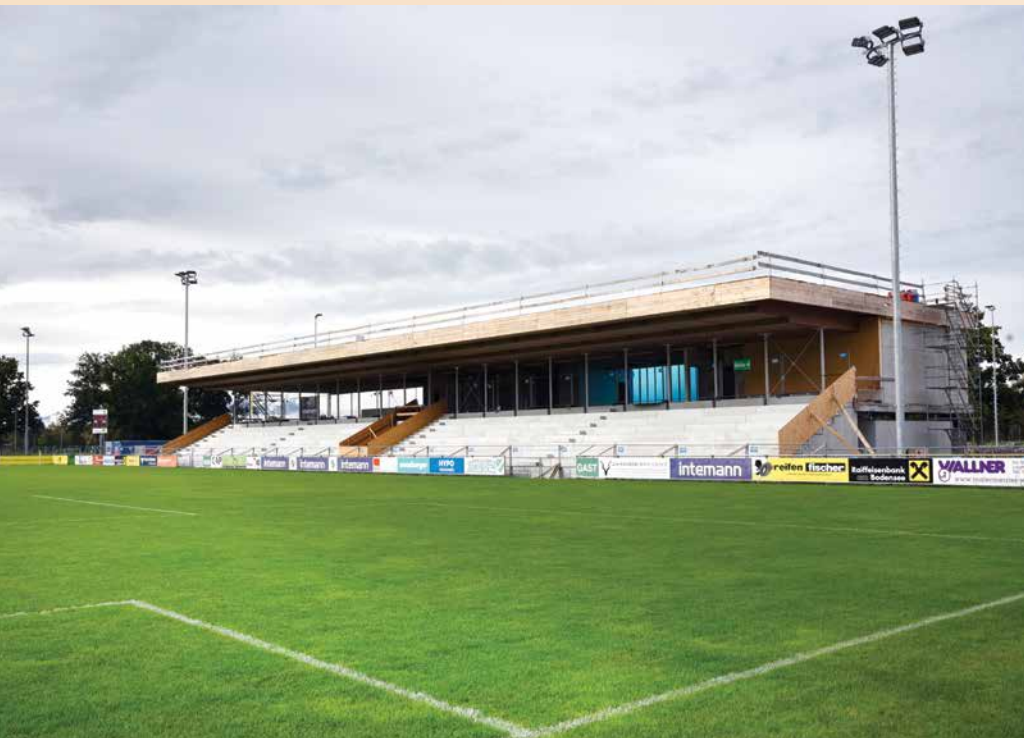
Die Tribüne ist fertiggestellt
