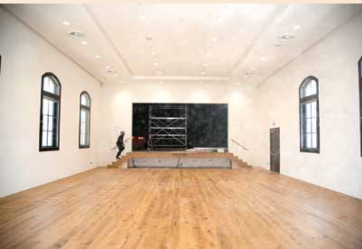
Der Bühnenraum ist fast fertiggestellt
