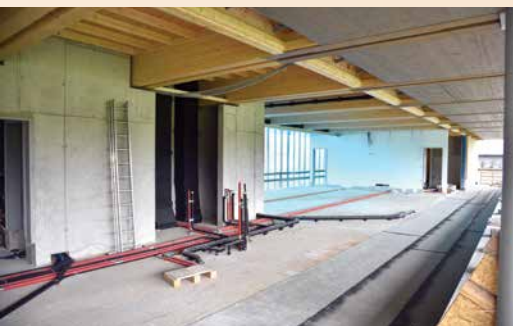
Ziel ist vor Wintereinbruch, die Verglasungen fertigzustellen
