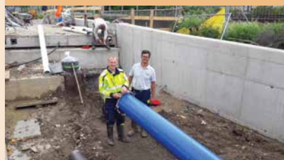
Die beiden Wasserwerkmitarbeiter Christian Rummer und Bernhard Quendler bei der Verlegung der Wassernotverbundleitung bei der neuen Radwegbrücke Forellenweg
