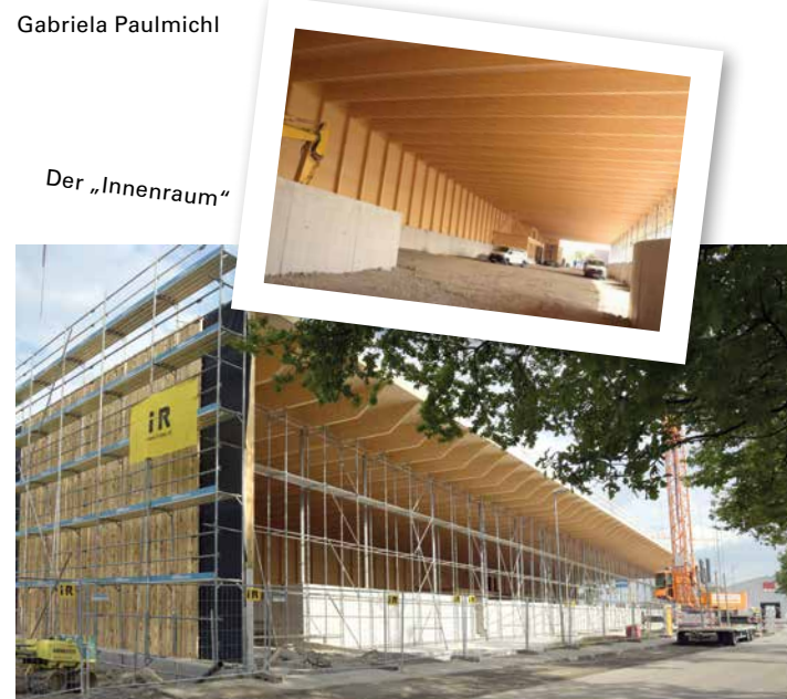
Mitte Juni begann die Anbringung der Holzverkleidung an den Außenwänden
