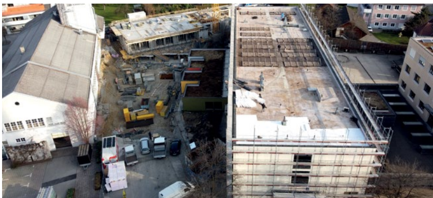
Die Arbeiten schreiten zügig voran
