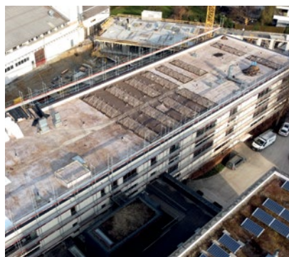
Für die Aufstockung des bestehenden Gebäudes wurde die Solaranlage abmontiert
