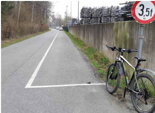
Öffentliche Parkplätze an der Zufahrt zur Sportanlage Ried (neu: Sportanlage Bruno Pezzey)
