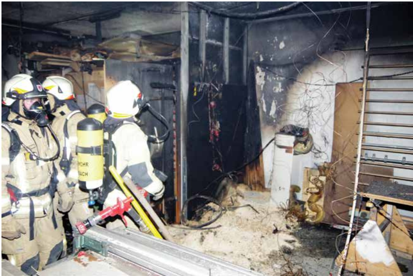
Brandeinsatz bei der Firma format
