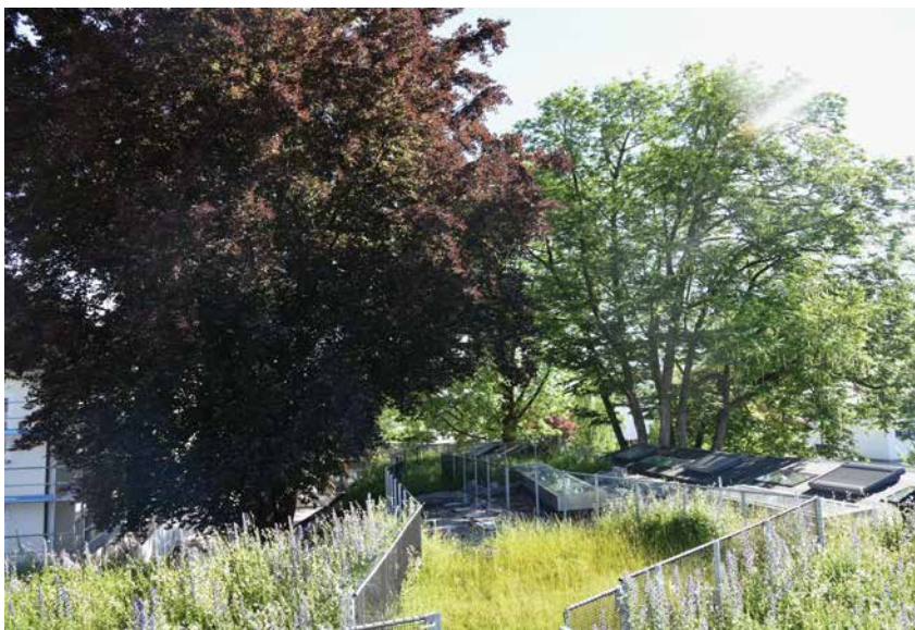
Das begrünte Dach der Volksschule Dorf mit dem alten Baumbestand im Schulhof
