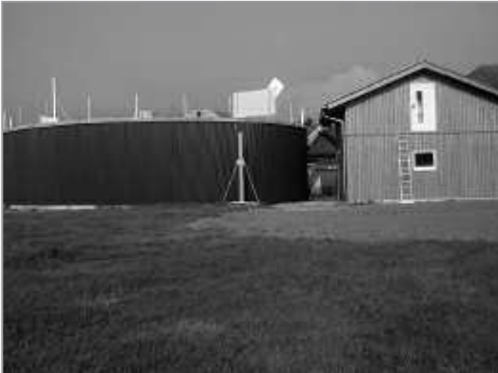
Fermenter und Betriebsgebäude
