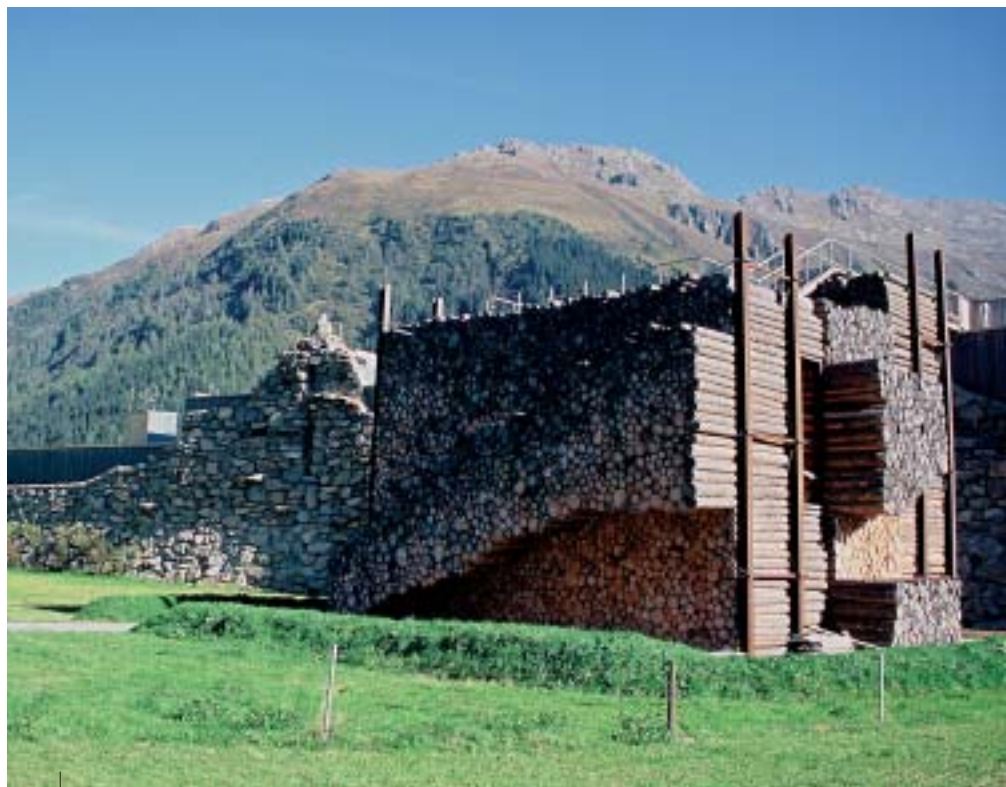
Die Mauer schützt Galtür vor den Sonnenberg-Lawinen
