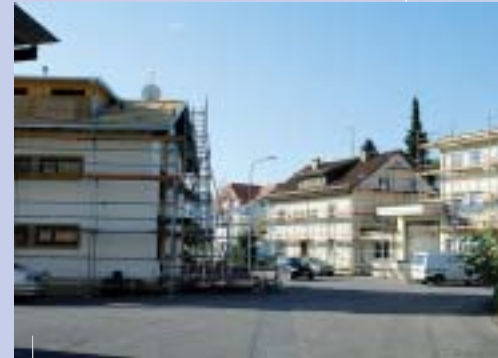
Baugerüste im Strohwinkel zum Anbringen von Wärmedämmung
