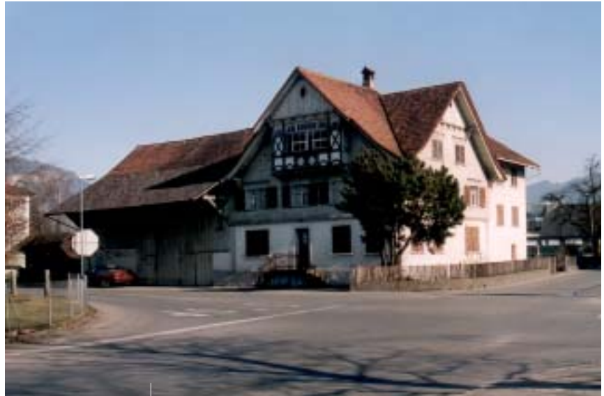
So zeigt sich das ehemalige Gasthaus zum Schäfle heute (Alte Landstraße Nr.6)
