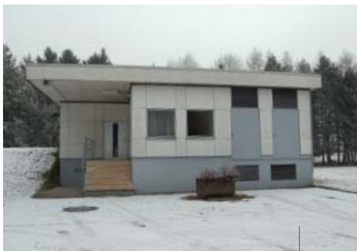
Unser Wasserwerk bei der Schule Unterfeld inmitten des Grundwasserschutzgebietes
