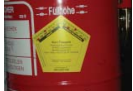
Feuerlöscher sollten alle zwei Jahre einer Überprüfung unterzogen werden
