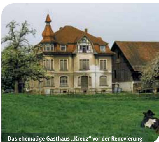
Das ehemalige Gasthaus „Kreuz“ vor der Renovierung
