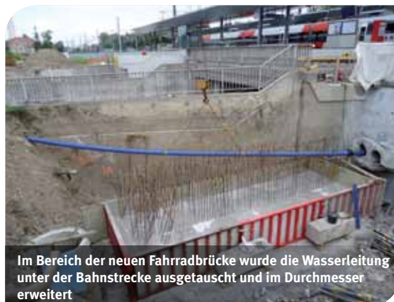
In der „Oberen Breigge“ wurden neue Wasserleitungen verlegt
