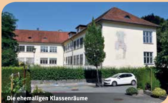
Abbrucharbeiten Volksschule Dorf
